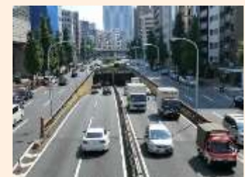
地下室や地下を通る道路など 周囲より低い場所
