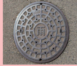
マンホールの蓋
